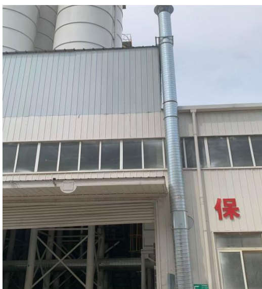
图 3-1 废气集气和除尘装置
