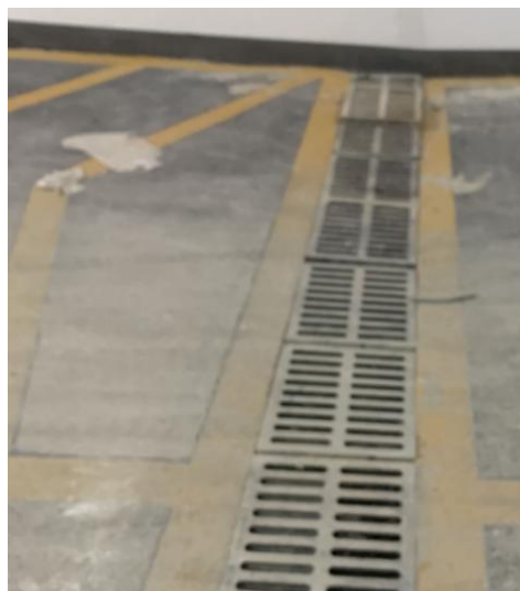
图 3-2 雨污分流及污水排放口
