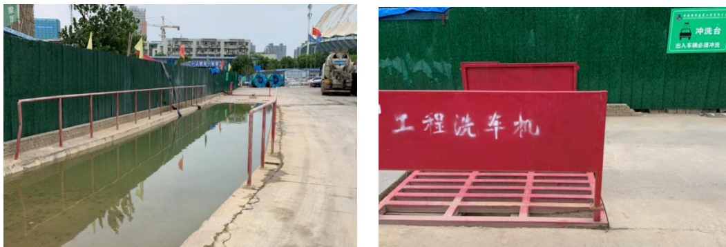
图 2-2 水洗槽、洗车机
