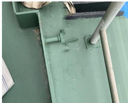
图 4-2 初期雨水控制阀
