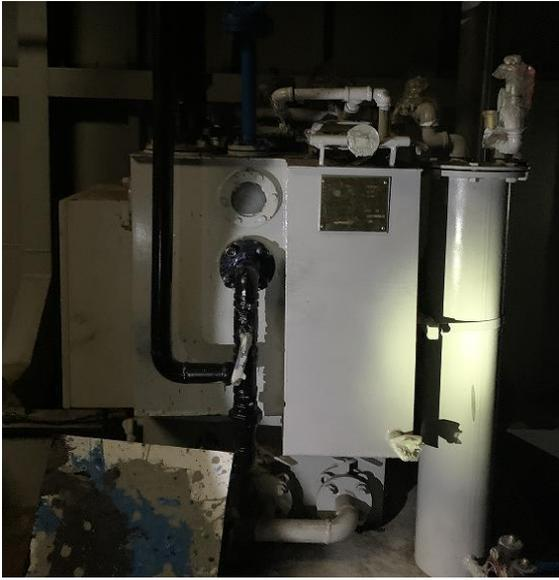
图 4-3 舱底一体化污水处理设施
