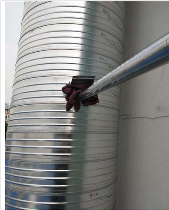
图 10-1 有组织废气采样照片
